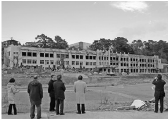
水没した沿岸部の小学校跡(石巻市)
