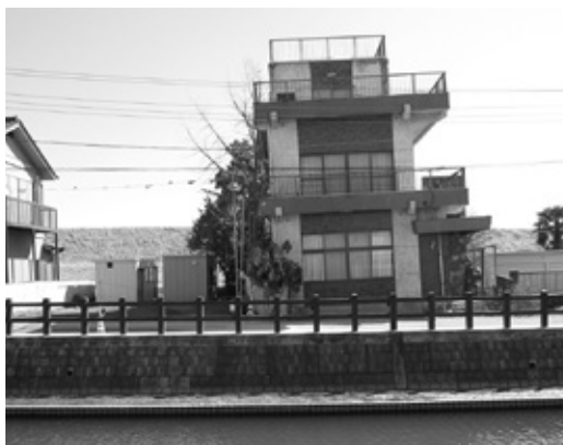
液状化で傾いた建物(香取市)
