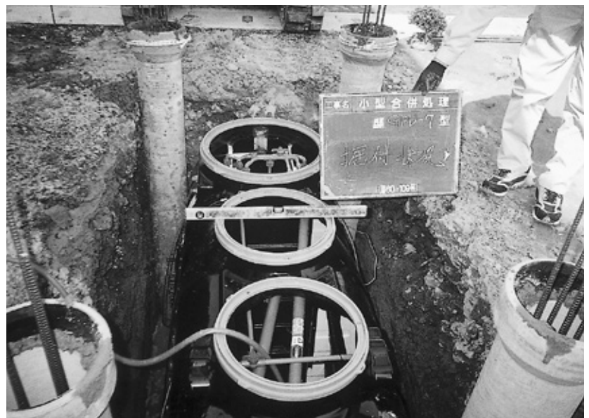
合併浄化槽設置工事の様子
