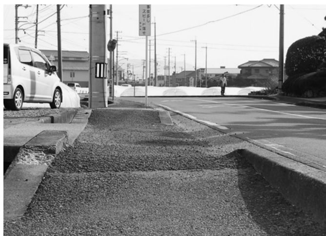
町道江ノ口新居須線の歩道
