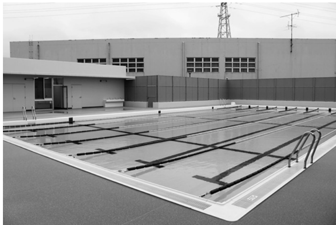
平成24年3月末に完成した藍住中学校プール
