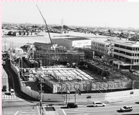
建設中の新町民体育館
