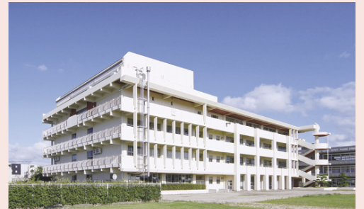
耐震工事が完了した藍住中学校南校舎
