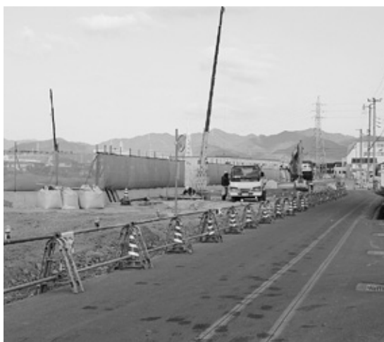
町道神蔵新居須線拡幅工事
