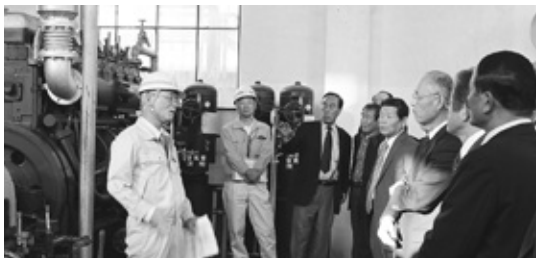
排水機場の視察
