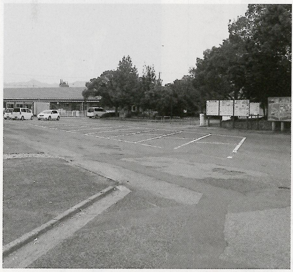
舗装・排水改修予定の福祉センター周辺
