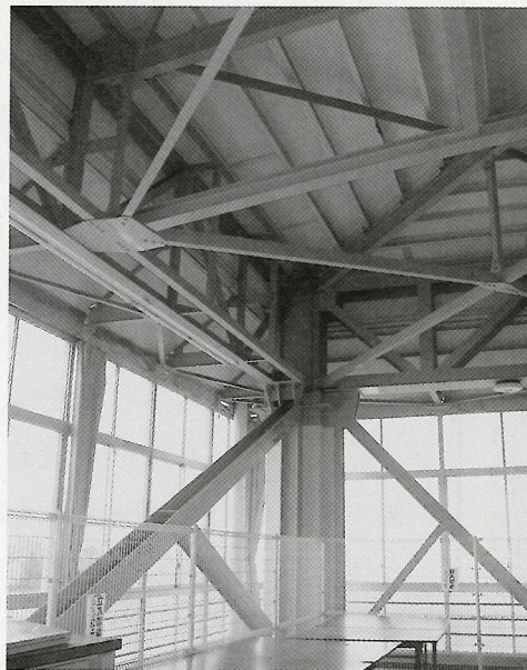
耐震補強工事済みの北小体育館
