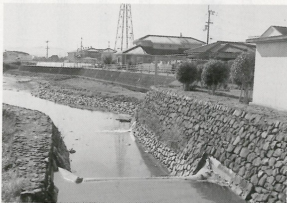
正法寺川（浄化設備）
