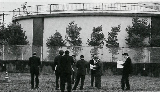
水道浄水場工事現場
