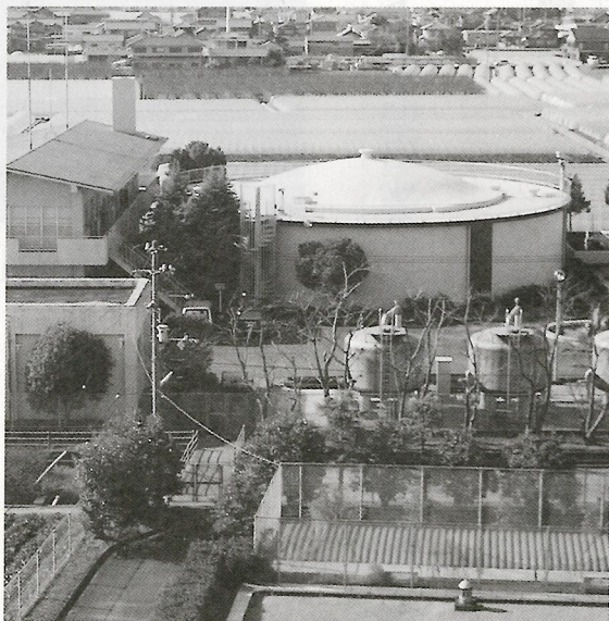
第2浄水場配水池（貯水タンク）
