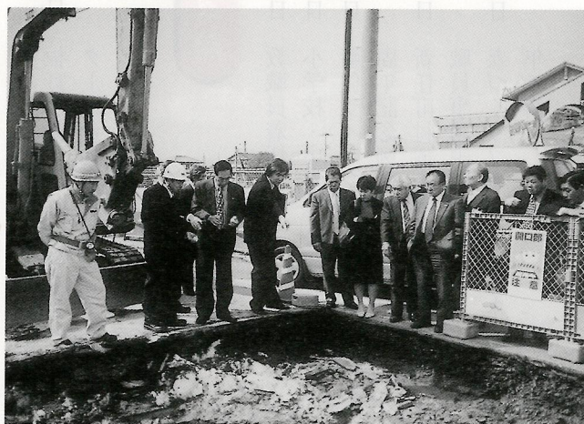
下水道工事の現場視察をする委員
