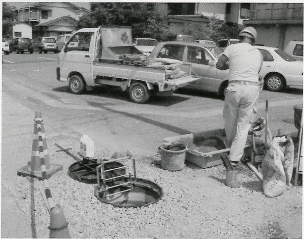
公共下水道管渠布設工事
