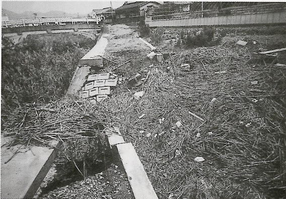
排水路に堆積した土砂等（前川付近）
