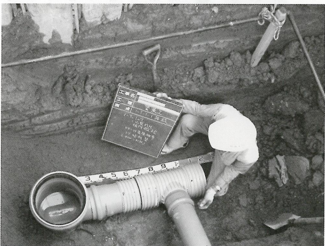
下水道マンホール設置状況
