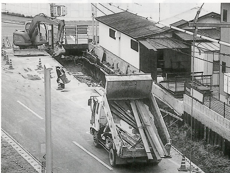
土木工事現場
