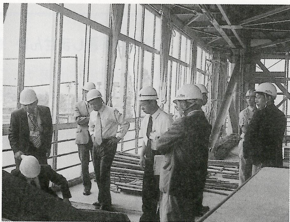
現場視察をする委員（藍住北小学校）
