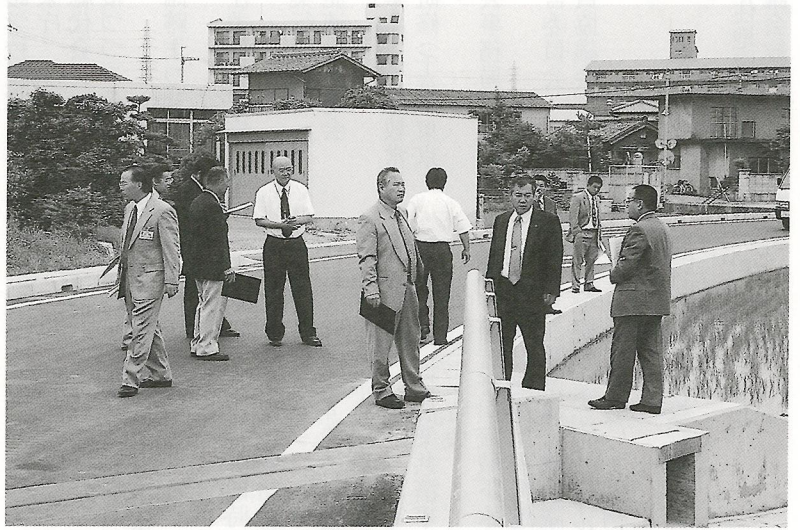
現場視察を行う建設産業常任委員
