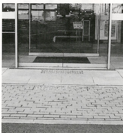
バリアフリーの自動ドア (合同庁舎正面玄関)
