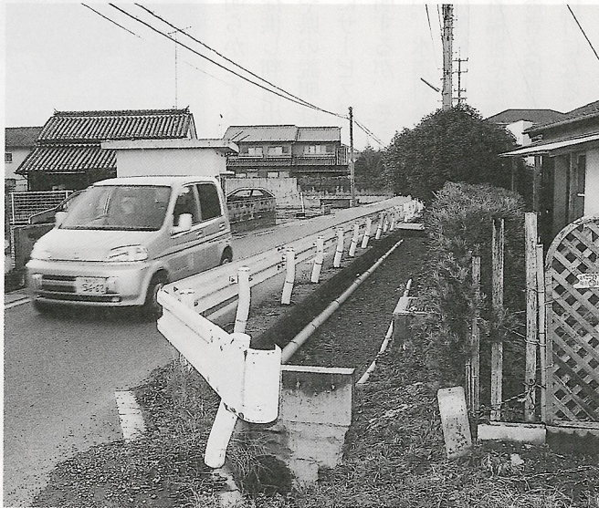
パイプライン化した幹線水路
