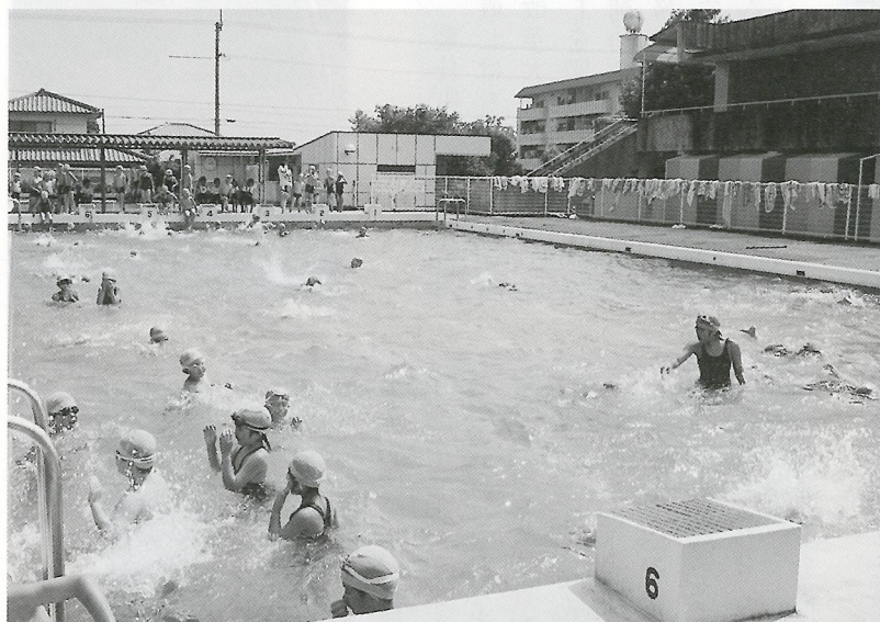
改修が望まれる北小学校プール
