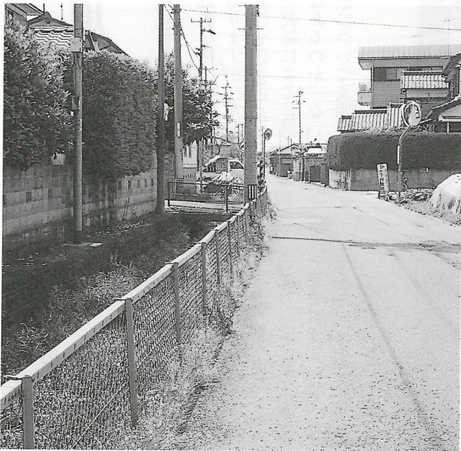
歩道整備が望まれる すみよし団地北側の道路
