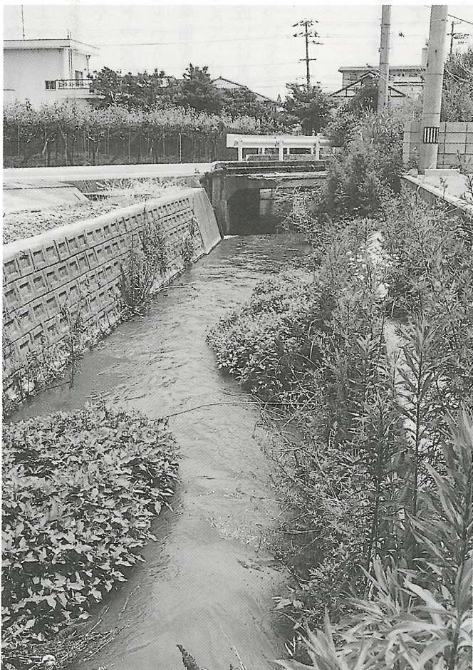
北千間堀の排水路
