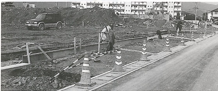
工事が進む桜づつみ公園
