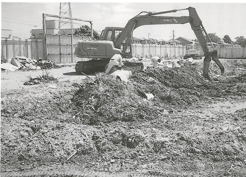
奥野土砂仮置場
