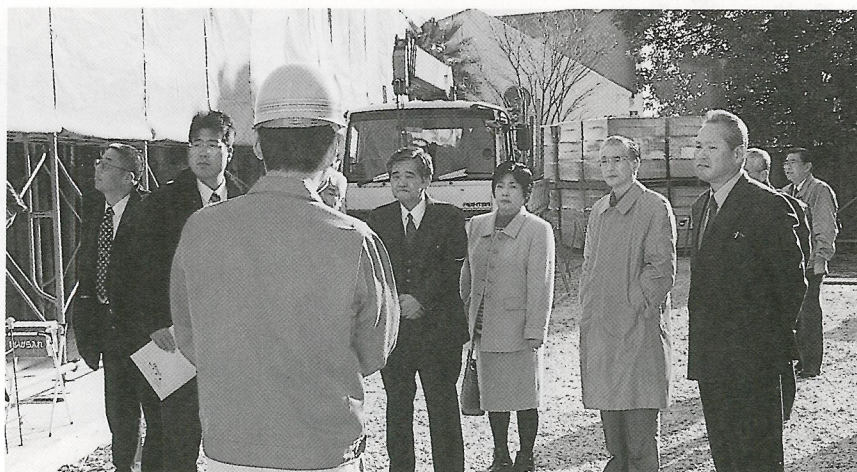
中央保育所建築現場
