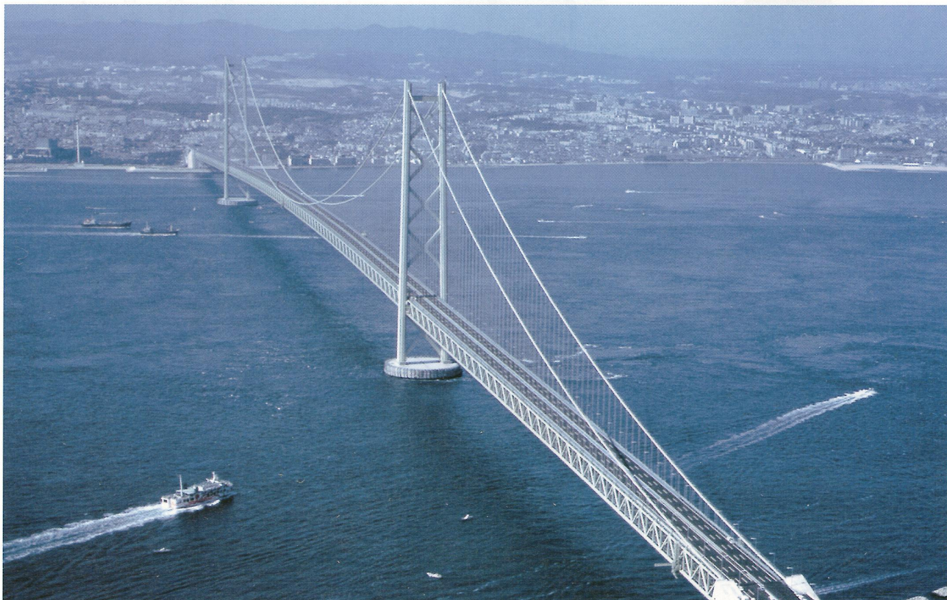
開通した明石海峡大橋
