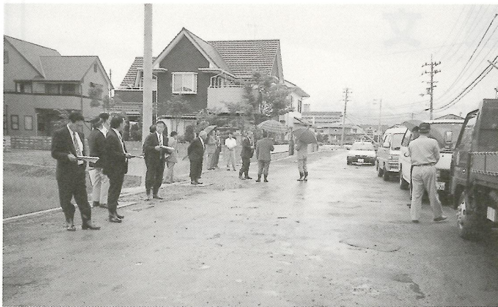
改良工事の進む勝瑞正喜地線
