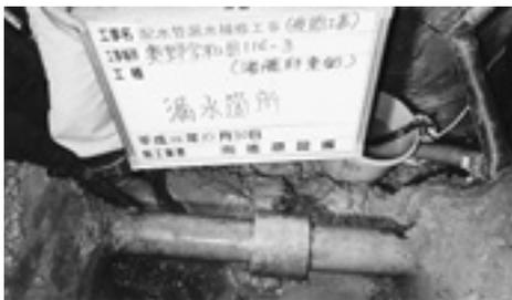
石綿管漏水補修工事の様子
