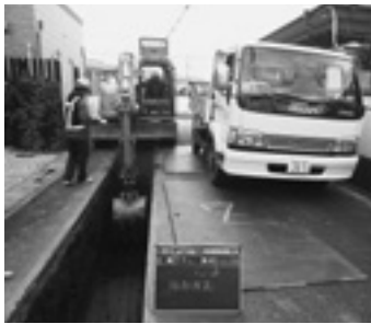
下水道管開削工事状況
