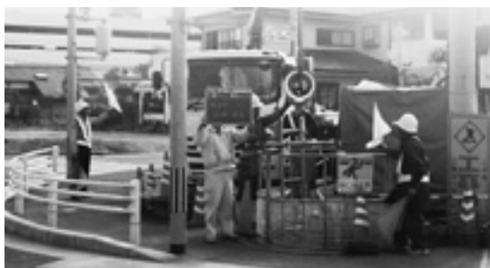
下水道推進管布設工事状況
