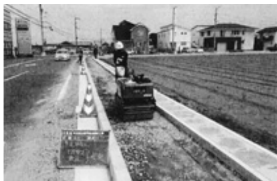
歩道の施工状況の様子（藍住南幼稚園北側）
