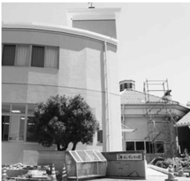
改修工事の様子（あいすみ保育園）
