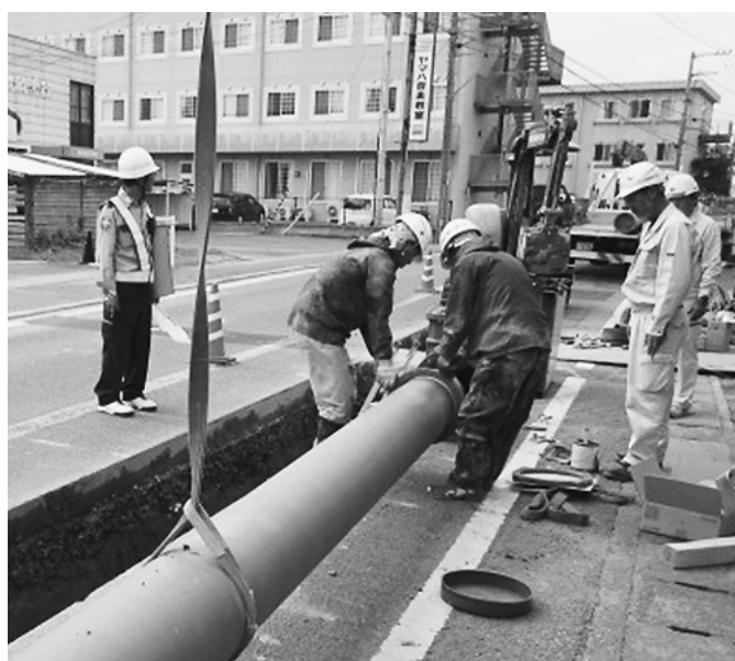
老朽管の耐震化工事の状況（勝瑞中富線）
