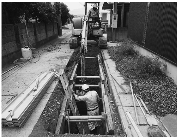
公共下水道南部支線管渠工事（奥野）
