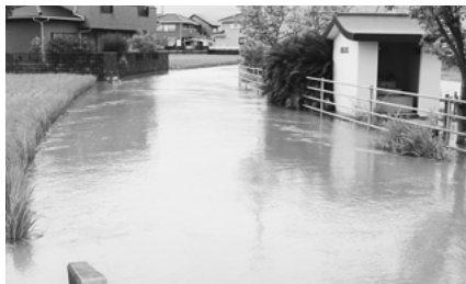
平成26年の台風で冠水した千間堀の状況
