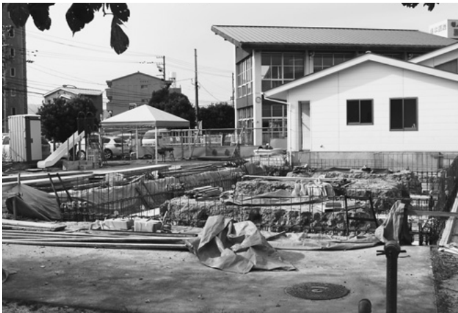
第2勝瑞放課後児童クラブ新築工事の状況
