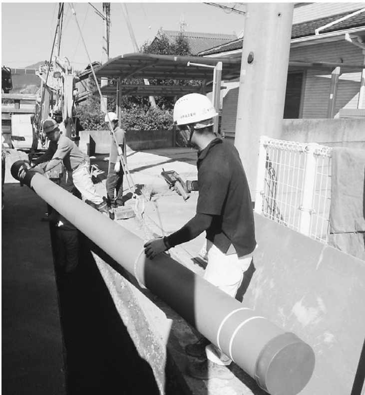
配水管布設替工事(耐震化工事)の様子 (町道矢上直道線)
