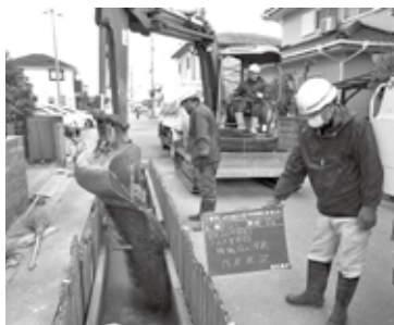
公共下水道工事の様子
