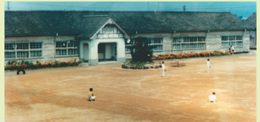
藍住北小学校旧校舎 （昭和54年に鉄筋コンクリートに建て替えられた）
