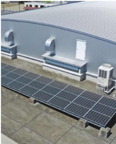
町民体育館に設置されている太陽光パネル
