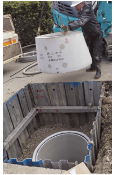
公共下水道管渠工事の様子
