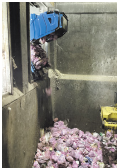
西クリーンステーション ごみピット
