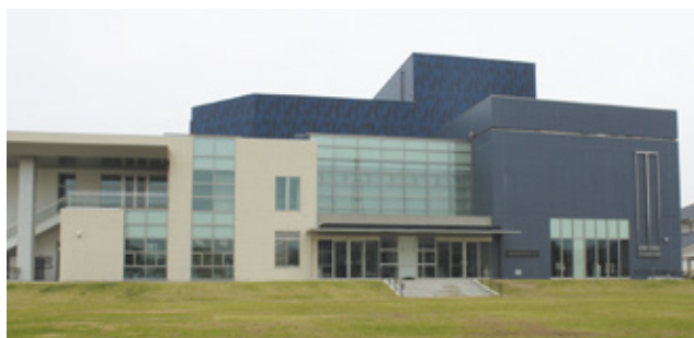
藍住町総合文化ホール
