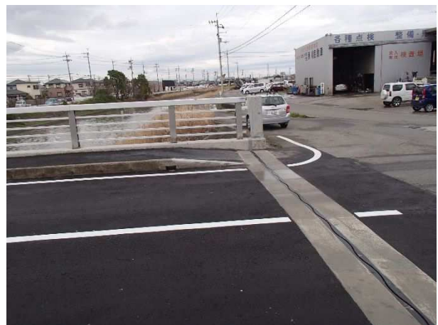
千鳥橋(舗装修繕工事実施)
