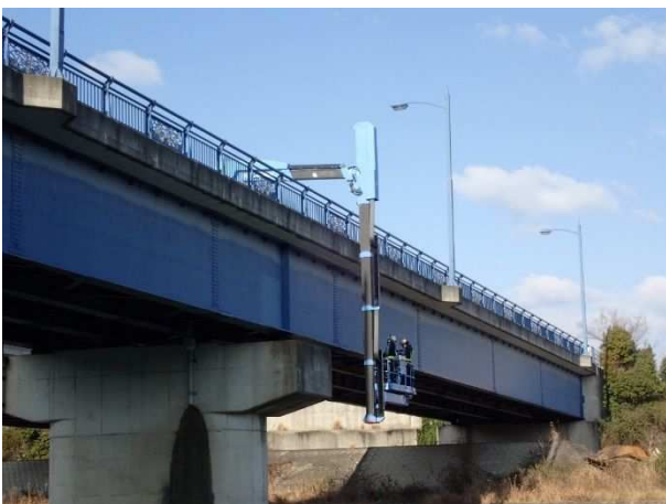
橋梁点検車による点検(中富大橋)
