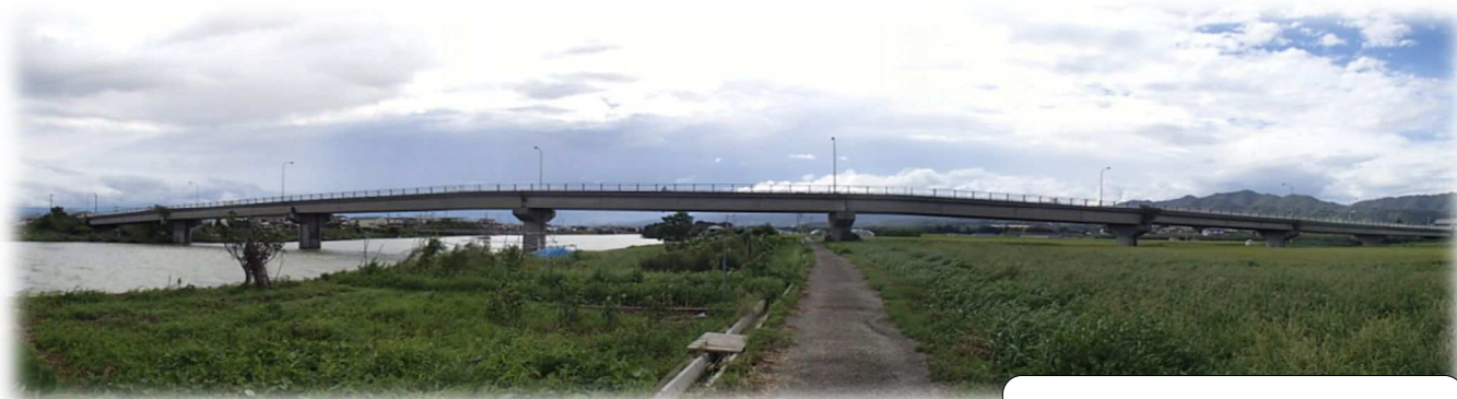
鳴門藍住大橋 1982年
