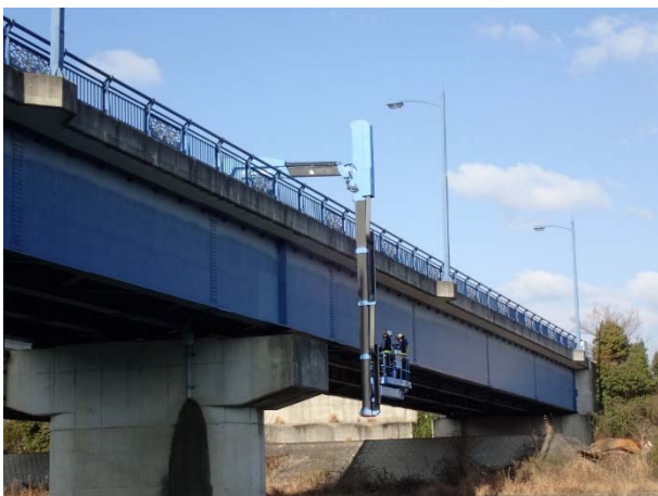
橋梁点検車による点検(中富大橋)
