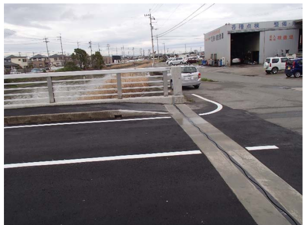
千鳥橋(舗装修繕工事実施)
