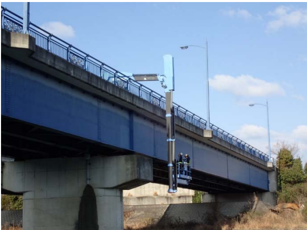
橋梁点検車による点検(中富大橋)
