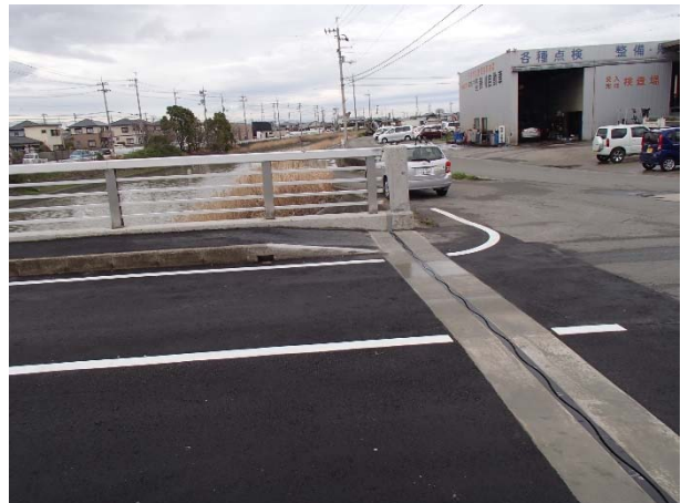
千鳥橋(舗裝修繕工事実施)
