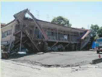
地震に耐えきれず倒壊した建物。周囲の道路には亀裂が生じている。
