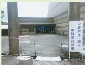
公費解体申請受付会場前 地割れにより入口付近も危険な状態
