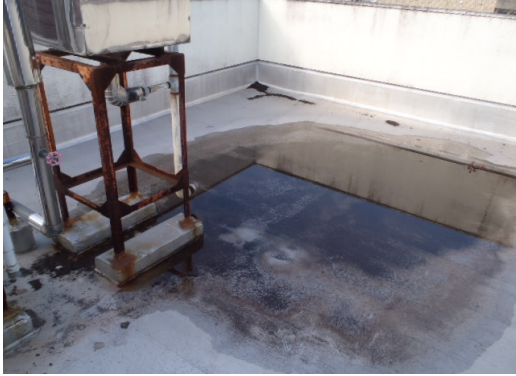
屋根材及び防水材の劣化・室内への漏水状況
