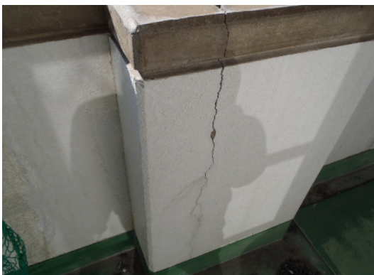
外壁の亀裂・樋の破損
