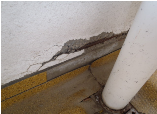
外壁材の劣化・鉄筋の爆裂
